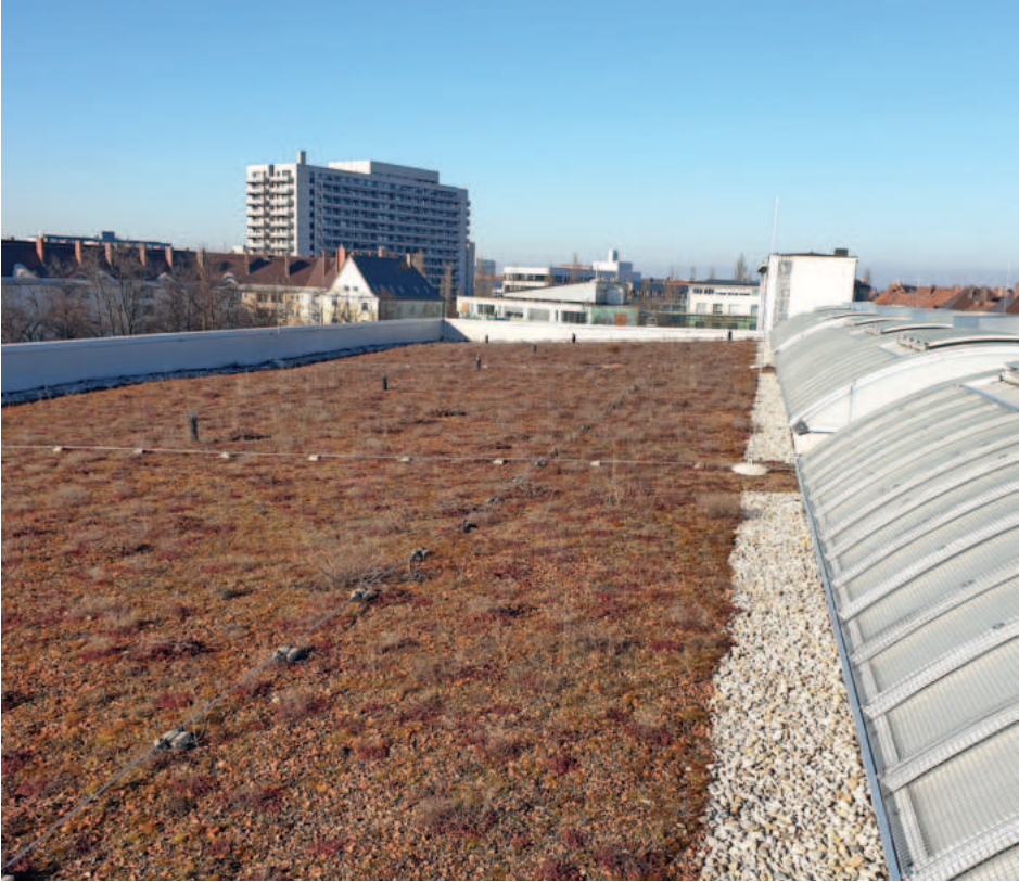
Hier wirds bald grün - das neue Hallendach hat eine vollständige Dachbegrünung erhalten.
